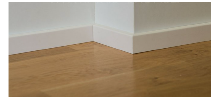
podlaha - dubové dřevěné lamely 490x70 mm, tl.11 mm, Duoparketa, PU lak soklová lišta - dubový profil 331 cm, na ležato, PU lak
